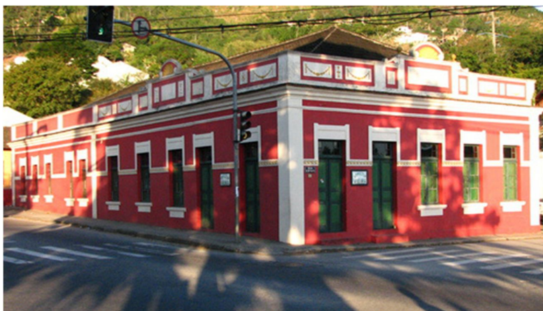
Figura 3: Estado atual do Armazém Vieira.
